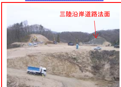
③施工：樋下建設
