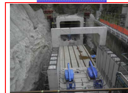
①施工：森本組
