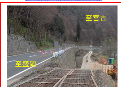
⑦施工：大成建設
